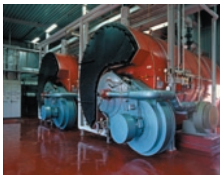
Turboflame brännare. SES-Turboflame för marina pannor.
